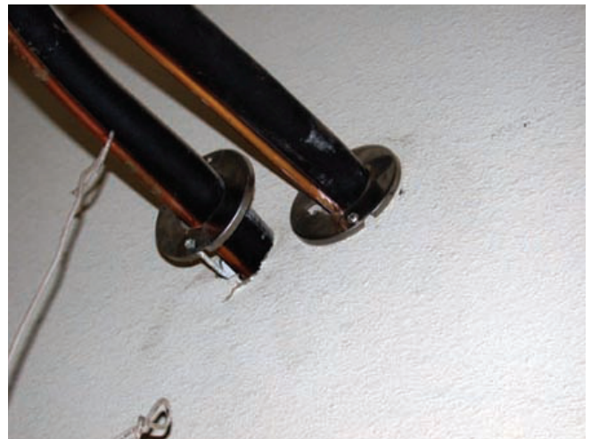
Loose escutcheon plates
